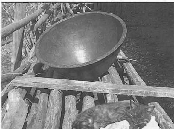
figura 4 - Copertura in vetroresina con "ospite" in primo piano.
